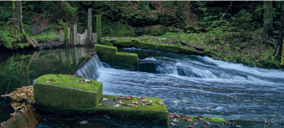
Abb. 2: Ein durchgängig gestaltetes Wehr an der Kirnitzsch in der Sächsischen Schweiz.
