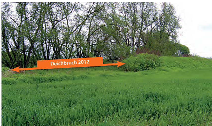
Abb. 8: Entwidmung des nördlichen Deichabschnitts der Deichanlage Sermuther Deich.
