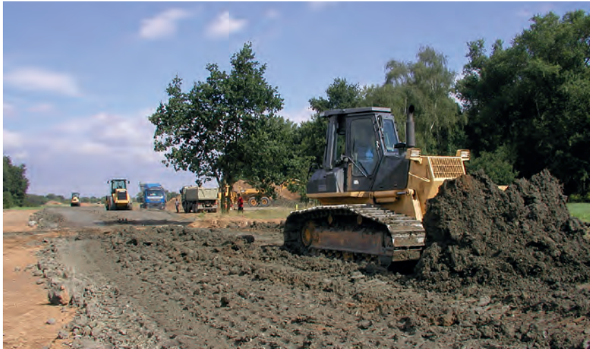
Abb. 9: Rückbau des Deiches nördlich der Schlossaue und Neubau des Hochwasserschutzdeiches in Eilenburg-West, 3. Bauabschnitt. Foto: Axel Bobbe
