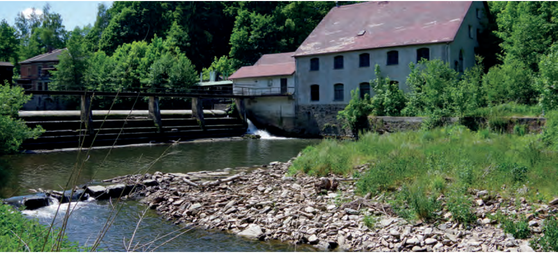
Abb. 7: Für Wasserlebewesen unüberwindbares Wehr einer Wasserkraftanlage an der Zschopau (Aufnahme vom 01.09.2015).
