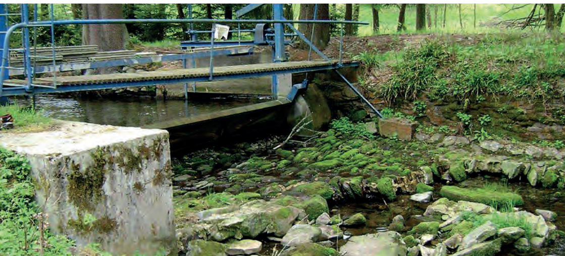
Abb. 6: Wasserkraftanlage am Pöhlwasser im Erzgebirge (Aufnahme vom 16.05.2017).
